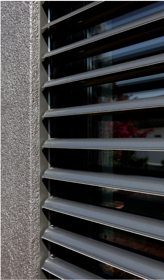
^ In der Laibung integrierte Führung für noch mehr Ästhetik (optional)
